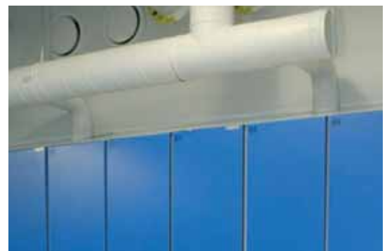
Poistoliitokset tehdään kaapin yläpuolelta.
